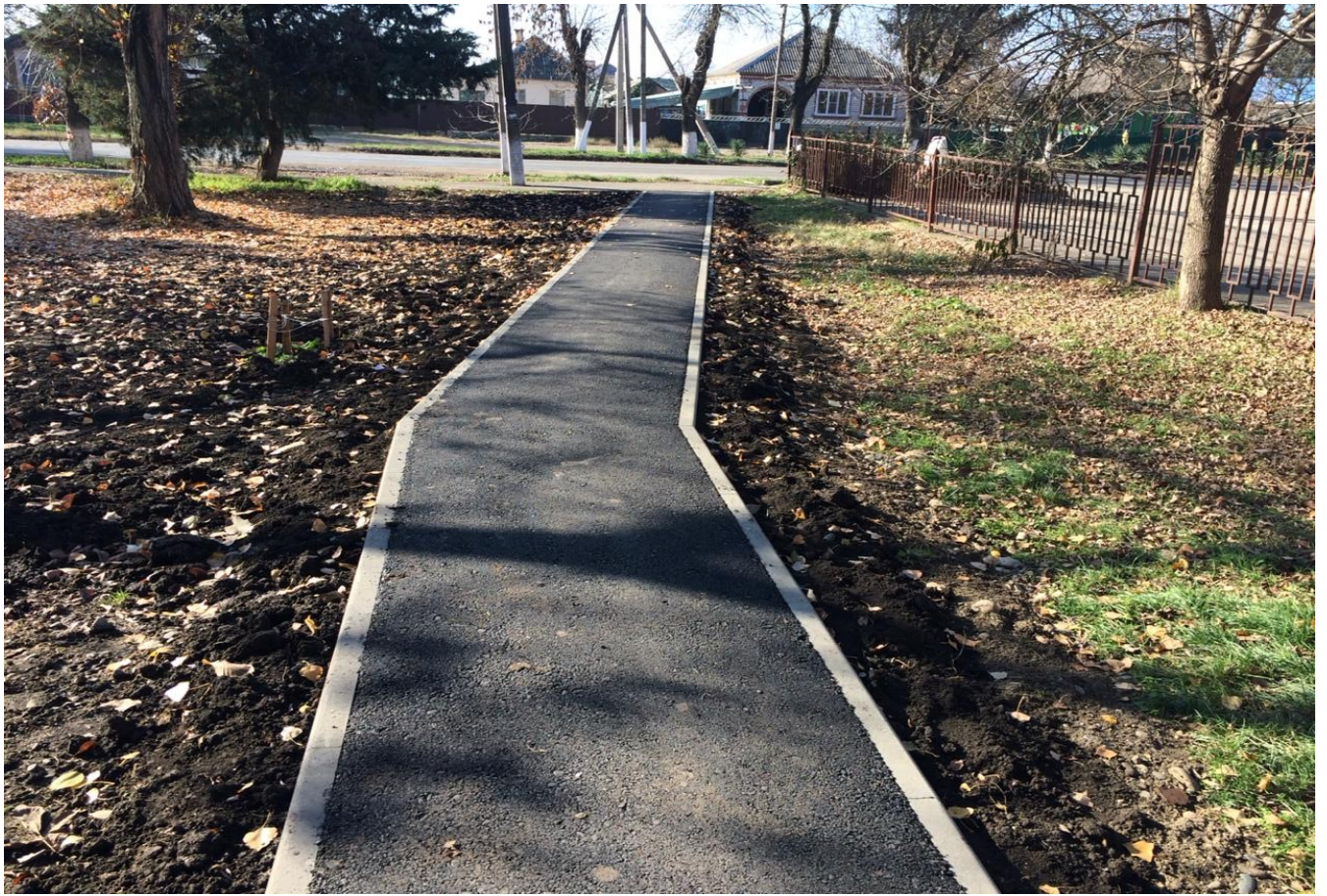
Ремонт тротуаров, пешеходных дорожек
