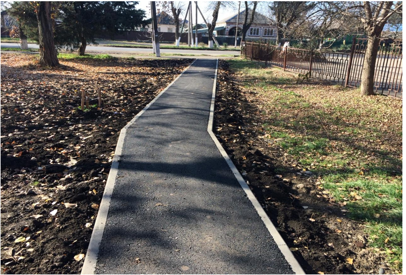
Ремонт тротуаров, пешеходных дорожек
