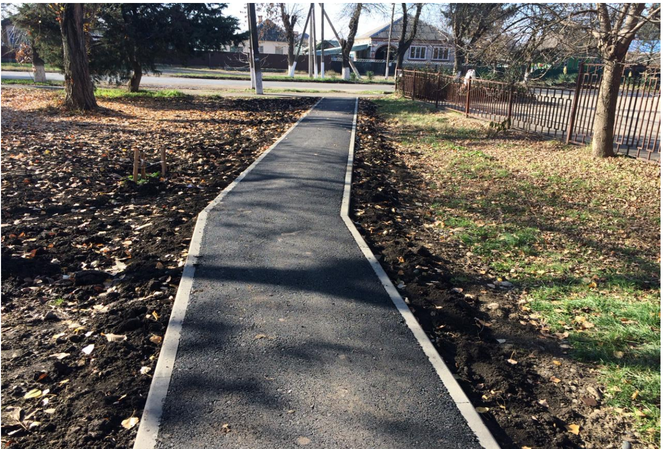
Ремонт тротуаров, пешеходных дорожек
