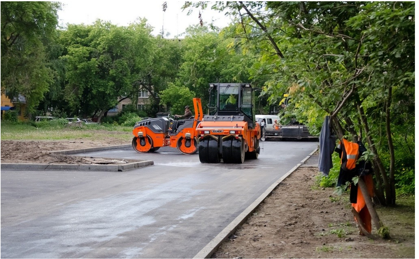
Ремонт дворовых проездов
