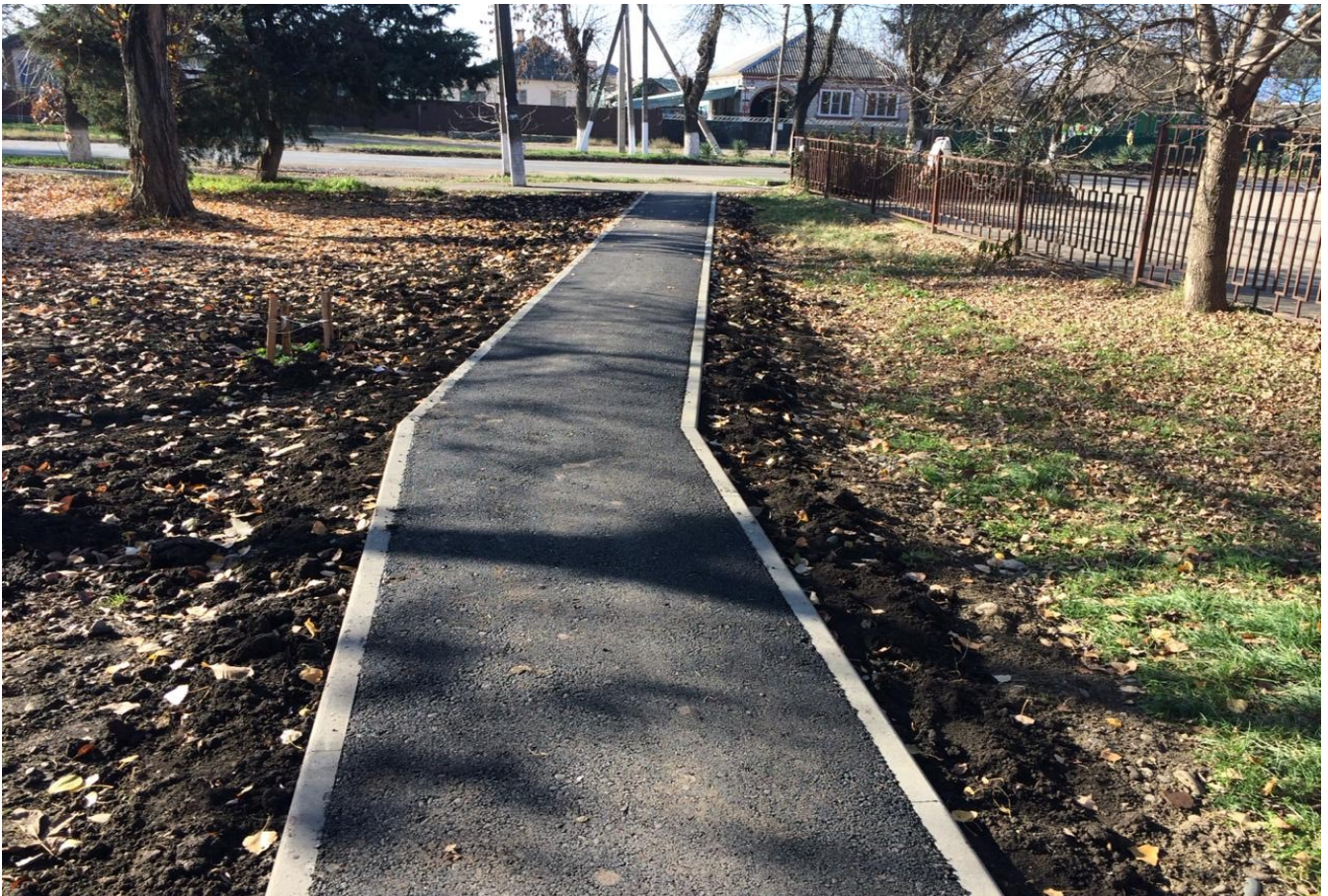
Ремонт тротуаров, пешеходных дорожек
