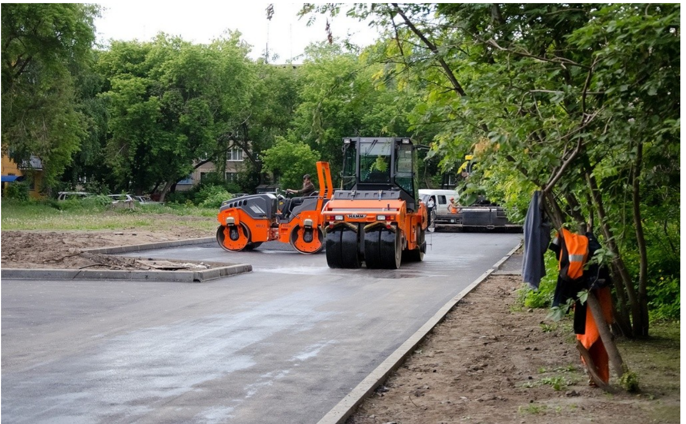
Ремонт дворовых проездов
